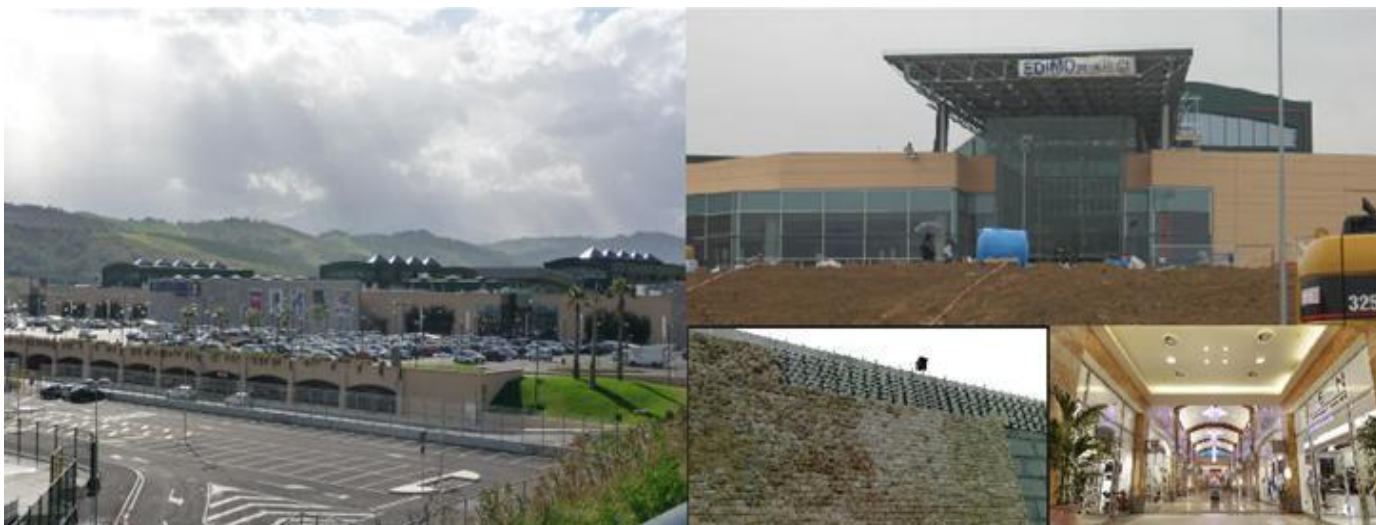
1) Progettazione strutturale e direzione dei lavori per il montaggio per la realizzazione del nuovo Centro Commerciale Gran Sasso in Località Piano D' Accio (TE)
