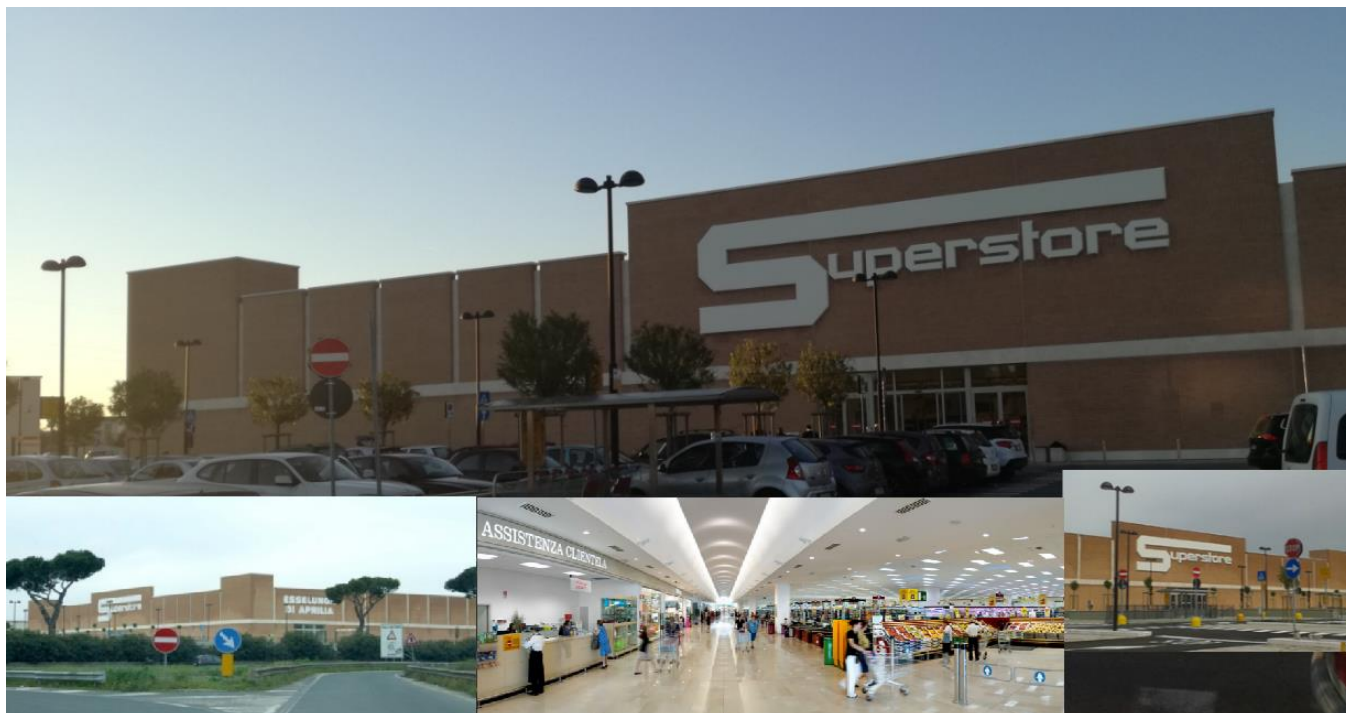
5) Progettazione strutturale delle strutture prefabbricate del Centro Commerciale ESSELUNGA APRILIA Spa e collaborazione nella progettazione delle strutture di fondazione per conto della ditta EDIMO Prefabbricati.
